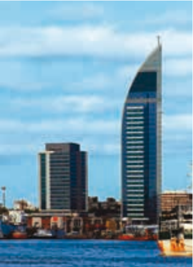
Complejo Torre de las Telecomunicaciones.
